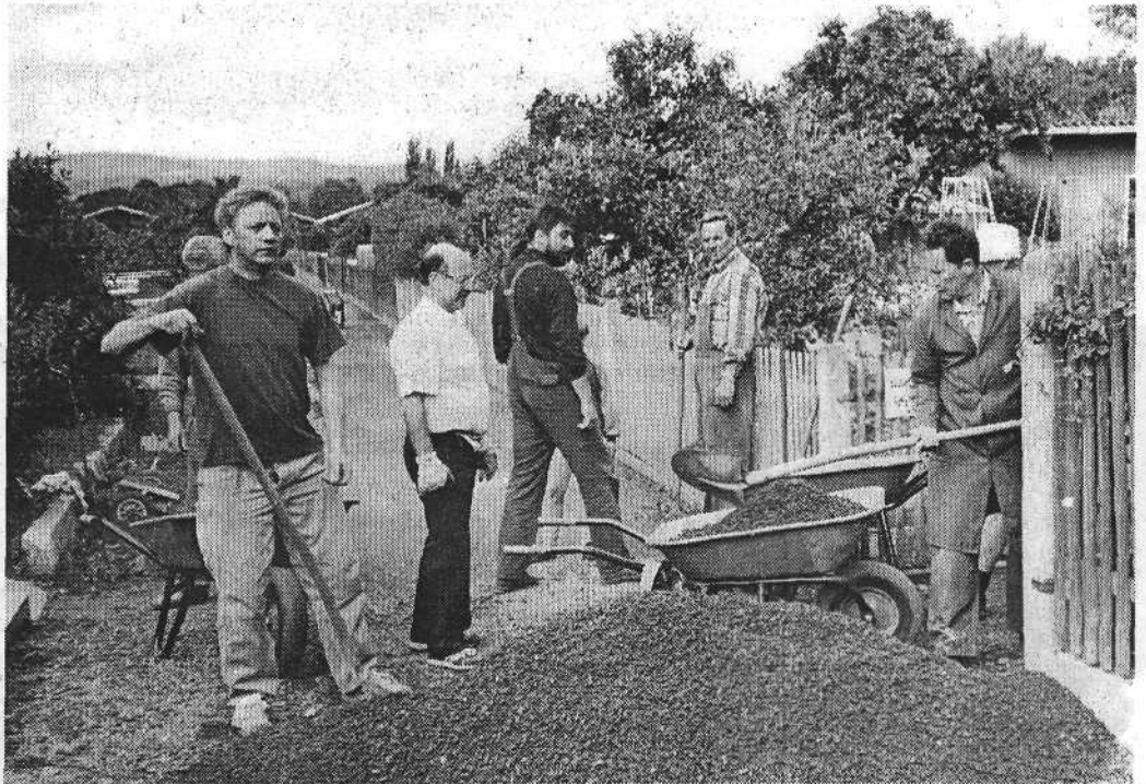
Nach dem Hochwasser wurde in der Gartenanlage aufgeräumt.
